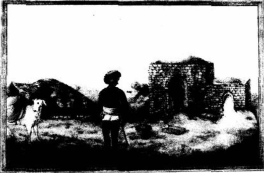
الشكل ٥-٣: نظام محارق الكلس شمالي الهند. تظهر صورة الآتون المكتبة البريطانية (British Library MS Add 27255, f. 348v.)
